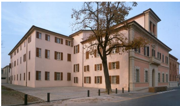
san lazzaro di savena, il restauro del palazzo comunale (andrea trebbi)
